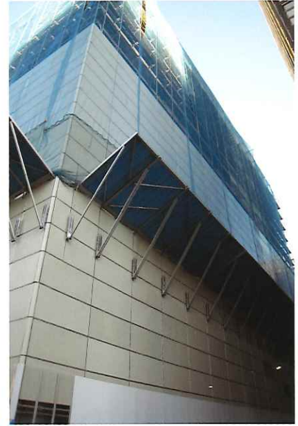
防音パネルの養生に使用
