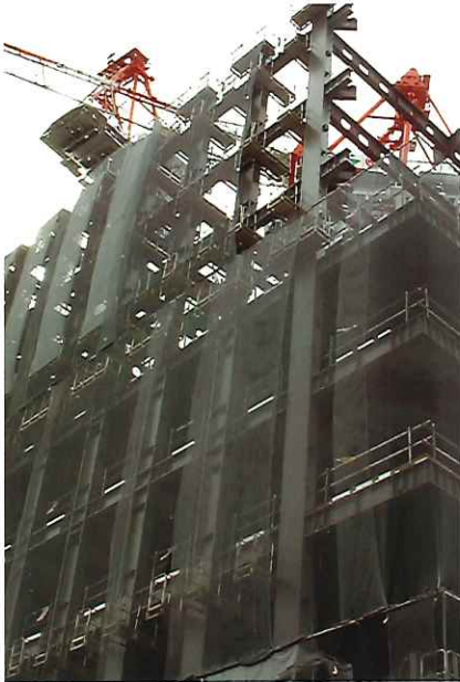
鉄骨建方に使用
