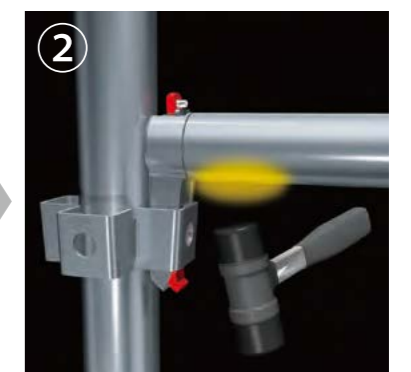
②手すりを叩き上げ、外す
